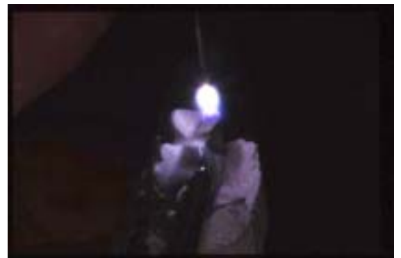
Foto 33 : Arcosaldatura dei perni (T.I.G.).
