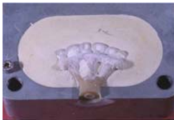
Foto 16 : La resina dopo l'iniezione.
